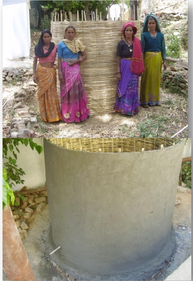
රූපසටහන 5.2.6.1 සහ 5.2.6.2: නිර්මාණය වෙමින් පවතින උණ බම්බු සිමෙන්ති පදනම් වූ වැසි ජල ටැංකිය
