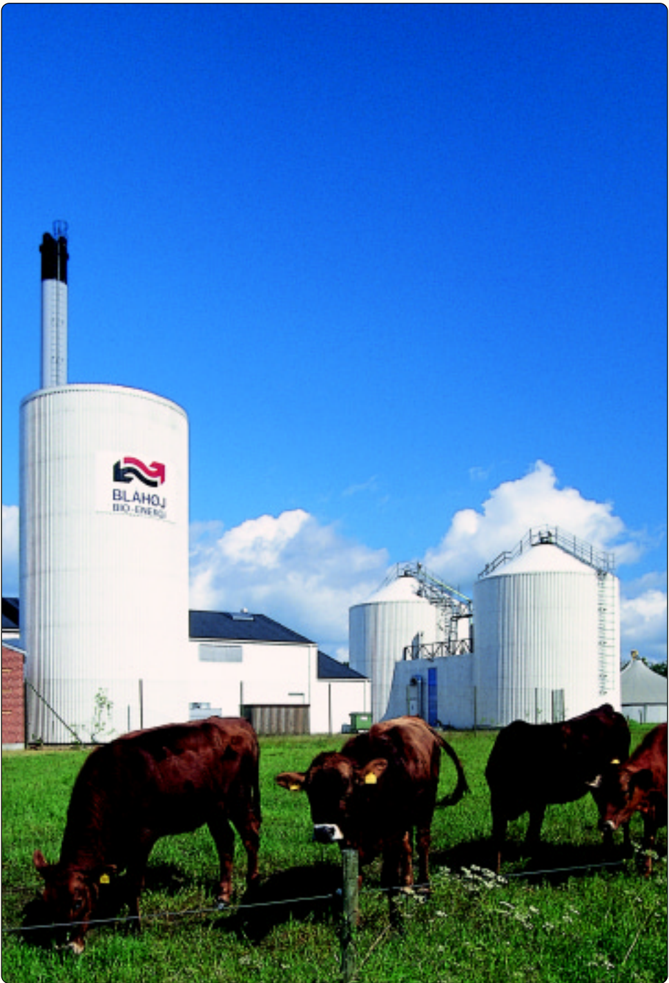
Biogasanlæg kan være med til at reducere landbrugets drivhusgasudslip. Foto: Torben Skott, Biopress
