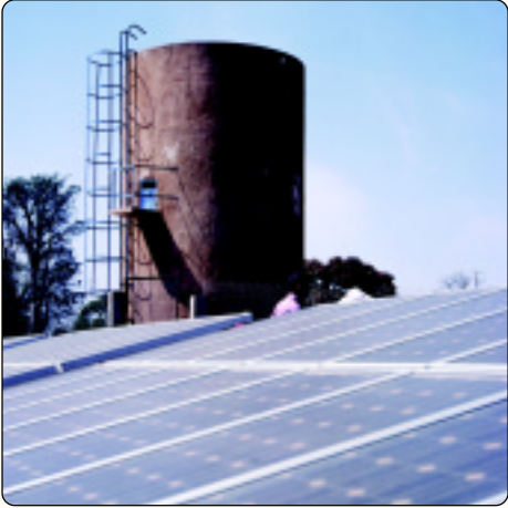
En soldrevet pumpebrønd som denne ved to landsbyer i Senegal kan sikre godt drikkevand til mange mennesker og dyr.
