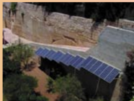
Ritratt ta' l-ewwel sistema privata f'Malta mqabba mal-grid li tipproduci elettriku mix-xemx
