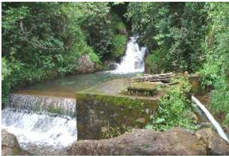
Barrage de Bamunkumbit
