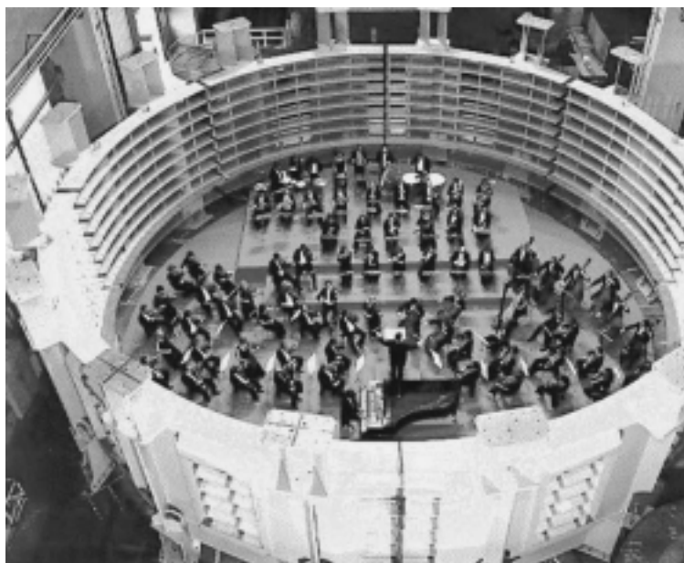
Stator najväčšej vodnej elektrárne na svete v Itaipu pojme celý orchester.
