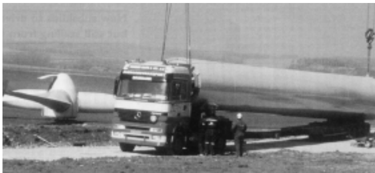
Preprava stožiaru 1,5 MW - ovej veternej turbíny.
