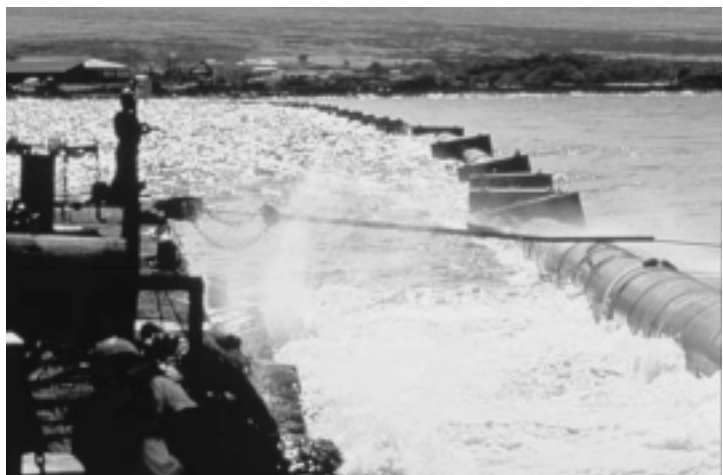
Zariadenie využívajúce energiu vln na výrobu elektrickej energie.
