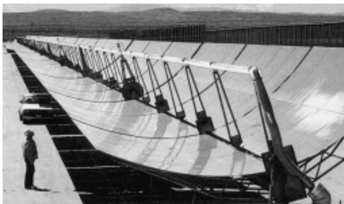
Solárna termálna výroba elektriny v púšti Mojave. Systém firmy Luz International.
